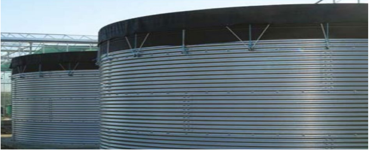
Fotoğraf 23: Seracılıkta Kullanılan Su Dinlendirme Depoları
