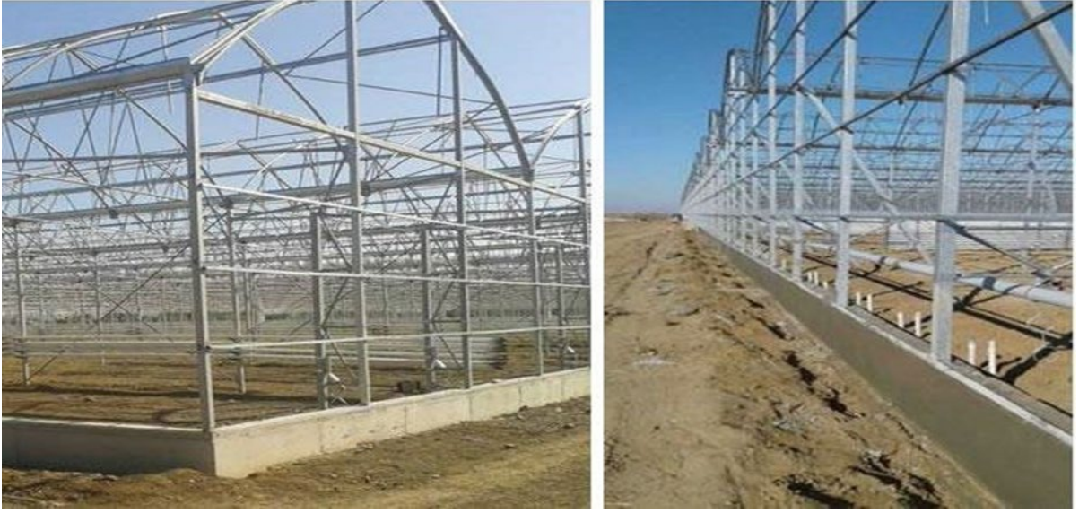
Fotoğraf 13: Çevre Temel ve Yan Perde Betonu
