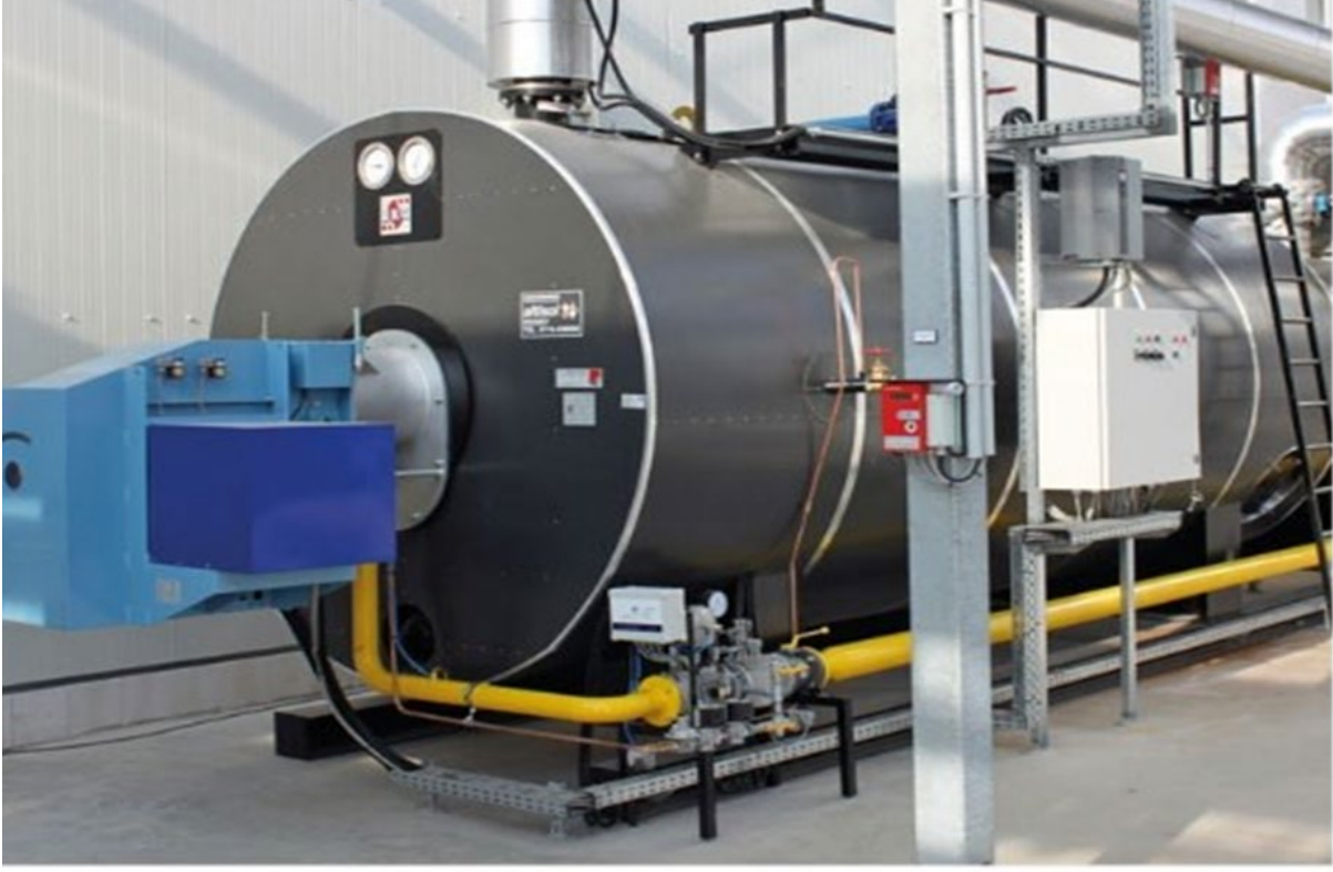
Fotoğraf 26: Seralarda Isıtmada Kullanılan Doğalgaz Kazanı
