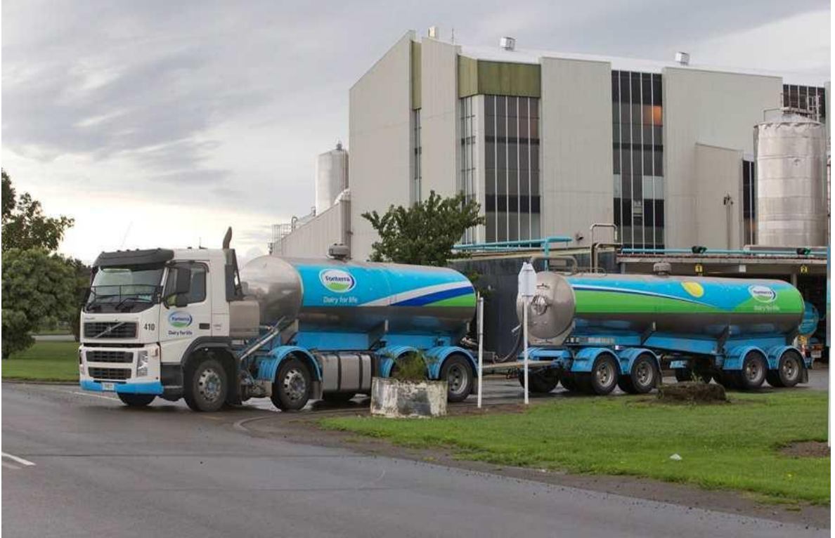
Fotoğraf 36. Fonterra Entegre Tesisi (Yeni Zelanda)
